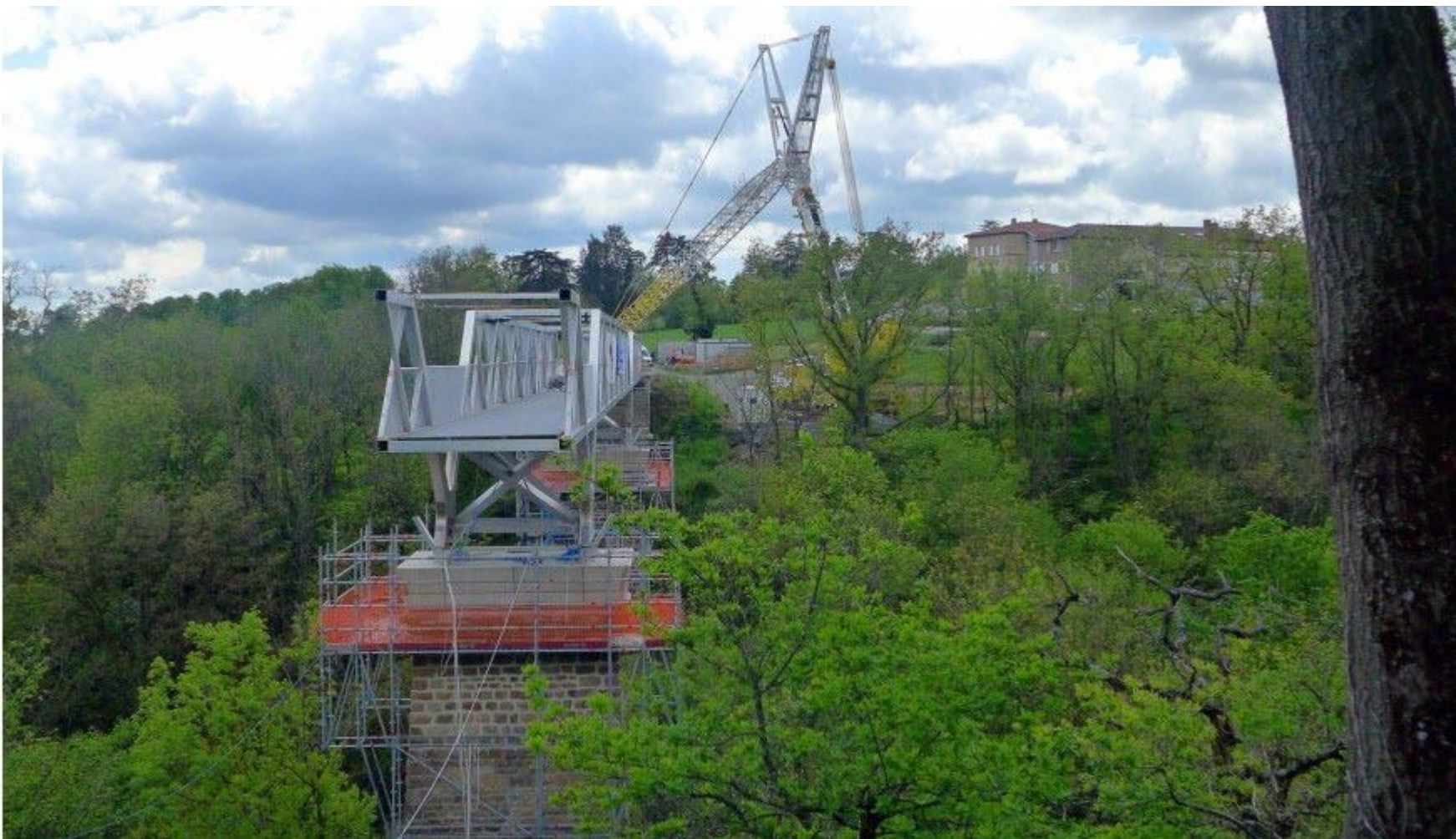
L'ancienne ligne ferroviaire du FOL (compagnie de Fourvière et Ouest Lyonnais), et celle de l'OTL (compagnie des Omnibus et Tramways de Lyon), ont connu leur heure de gloire entre la fin du XIXe siècle et la première moitié du XXe. (Photo Thierry Huot)
