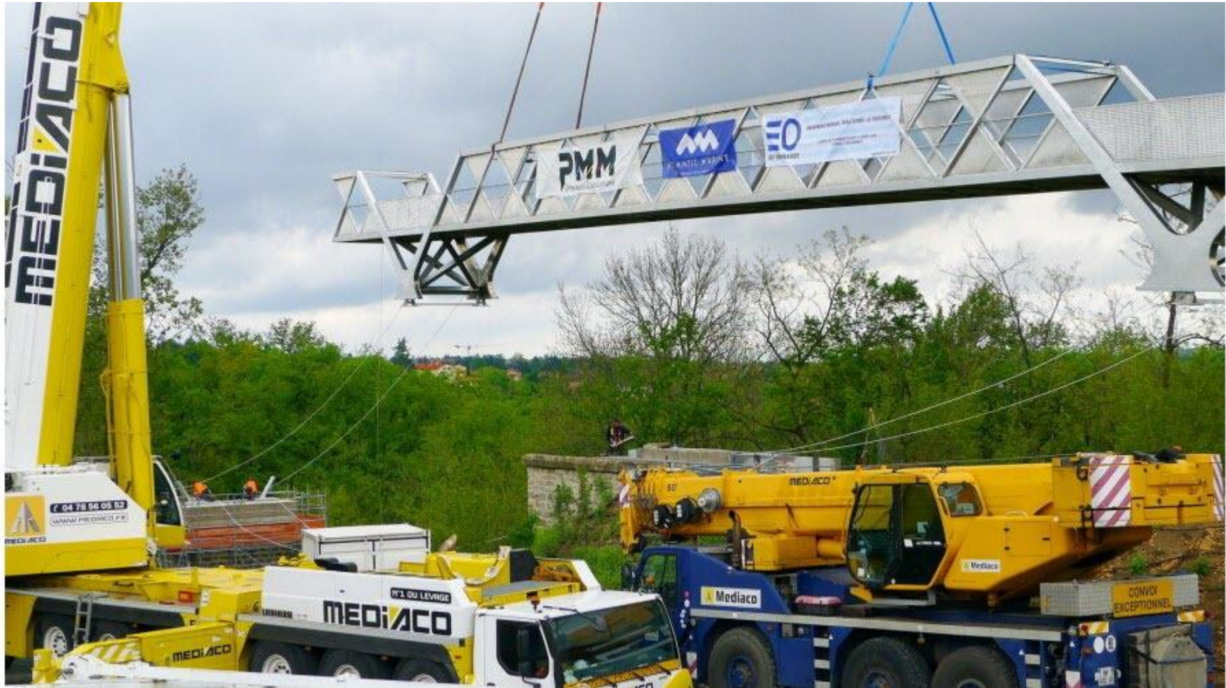
Un tronçon de passerelle comme suspendue en l'air. (Photo Thierry Huot)
