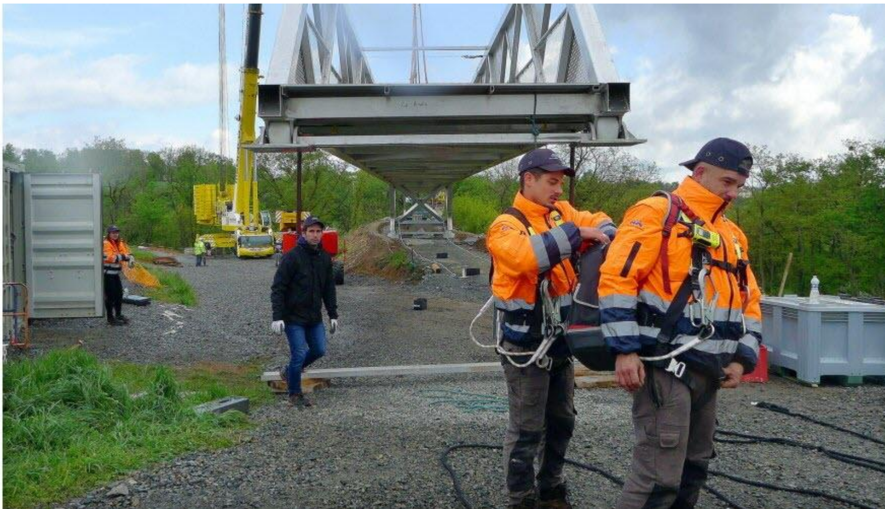
Une partie de l'équipe s'est outillée de matériel de sécurité afin de procéder au scellement des différentes parties de l'ouvrage en aluminium. (Photo Thierry Huot)
