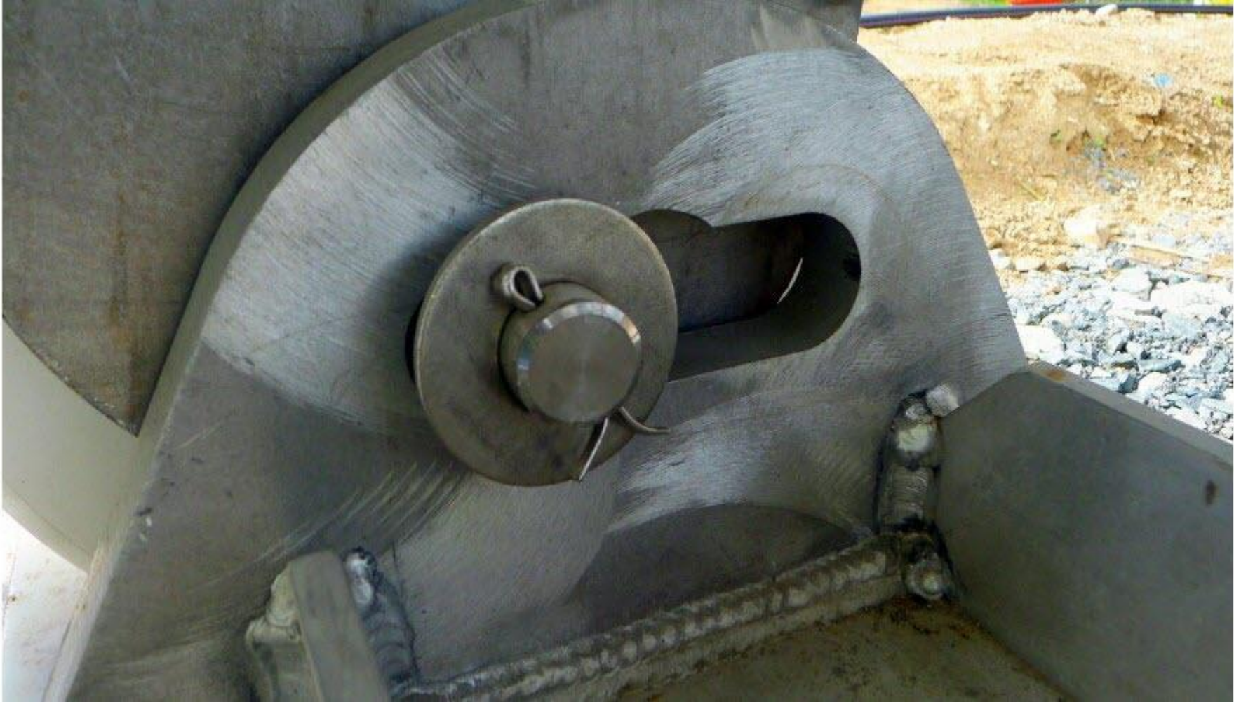
Environ 10 cm d'axe de dilatation est prévu entre l'été et l'hiver. (Photo Thierry Huot)
