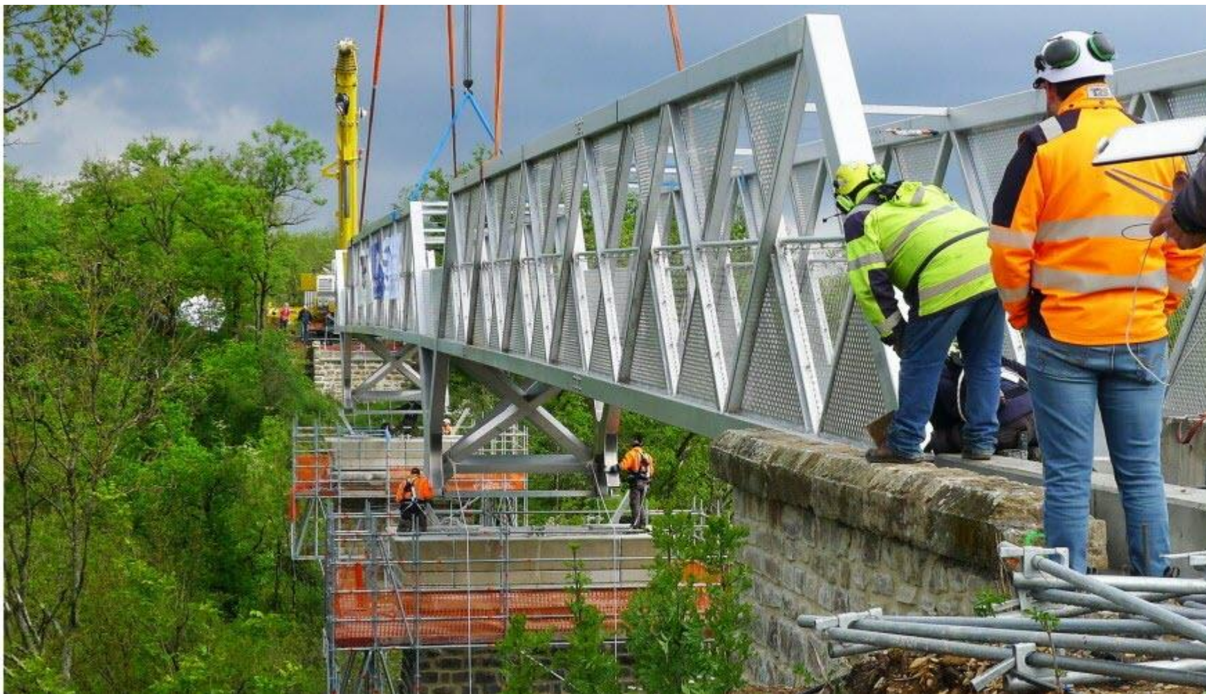
Le tablier est posé sur la culée, côté Brindas. Il doit maintenant être positionné sur les deux piles du viaduc. (Photo Thierry Huot)
