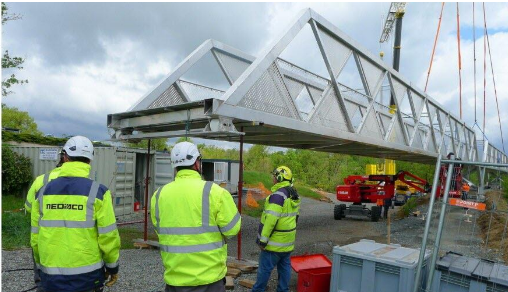
La réalisation de la passerelle a représenté un an de travail, dont six mois d'usinage, d'assemblage et de soudure. Photo Thierry Huot
