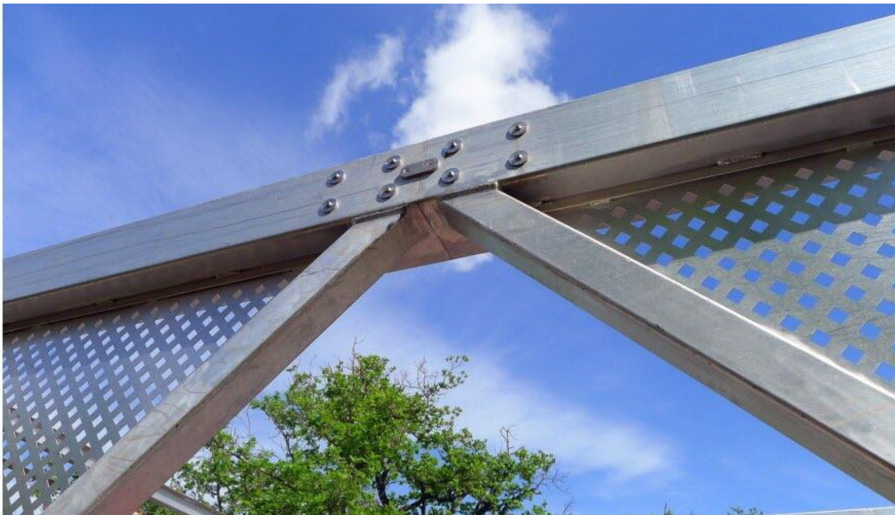
Mise en place des broches et des boulons de liaison entre les éléments. (Photo Thierry Huot)
