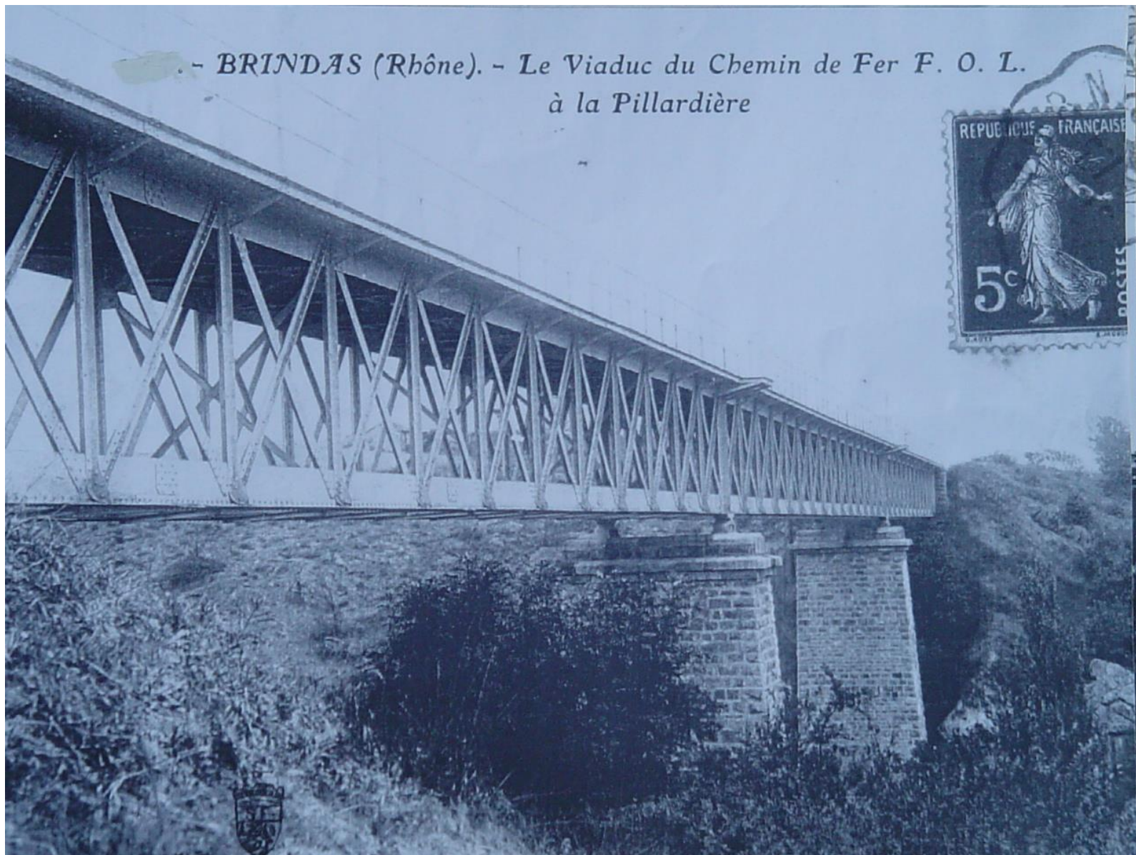
Viaduc de la Pillardière au temps de la circulation des trains puis des tramways
