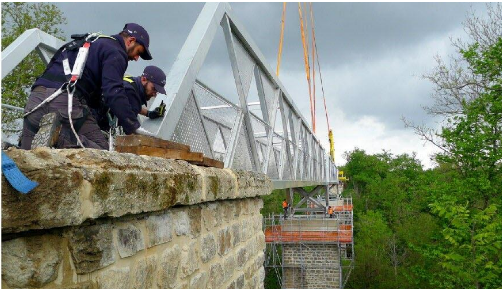
Sur une passerelle en aluminium, la dilatation est d'environ 1 millimètre par mètre. (Photo Thierry Huot)
