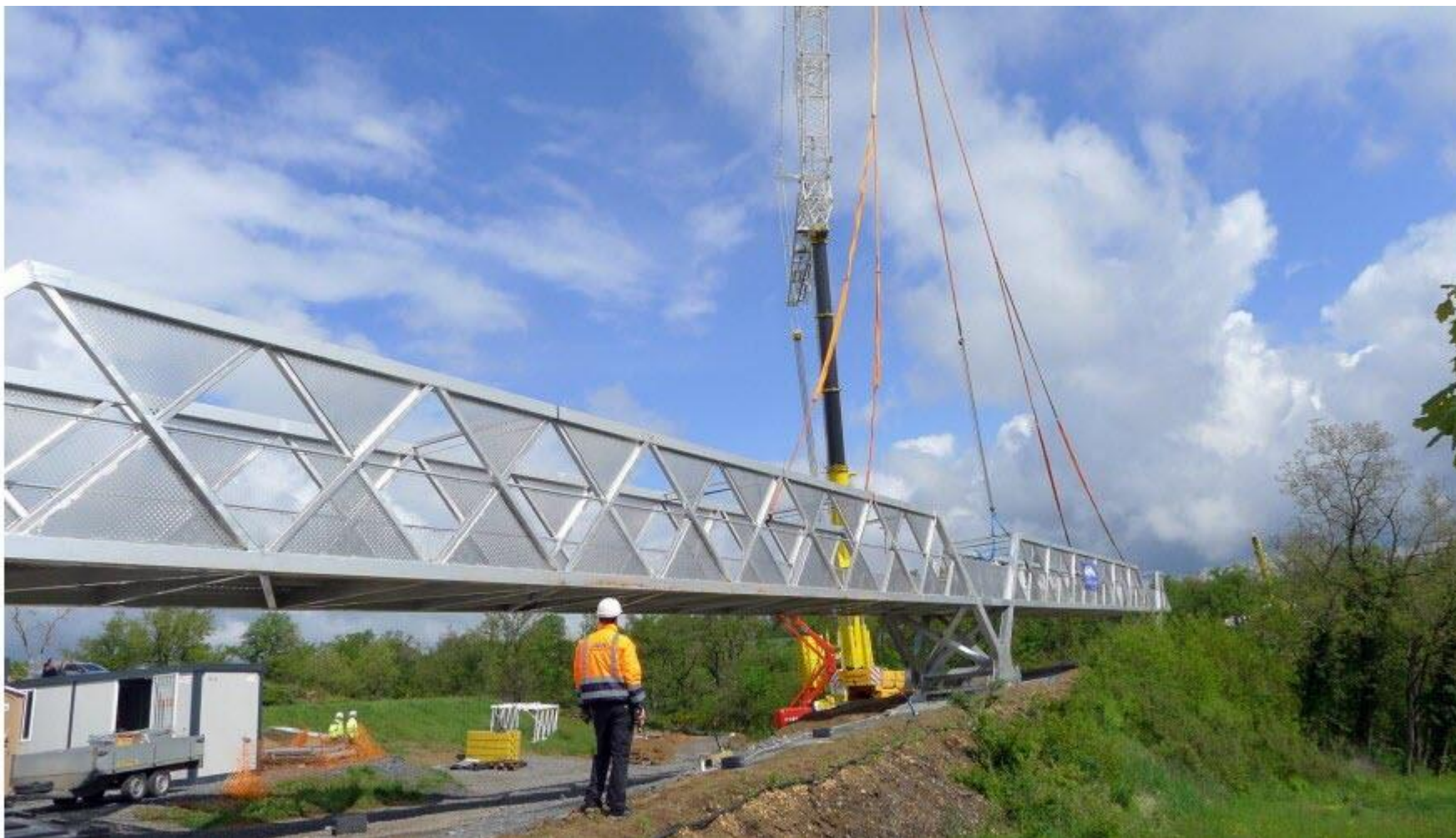
Environ 45 mètres d'élingage ont été fixés de la flèche au tablier. L'ouvrage d'art, de 110 mètres de long, va relier Brindas à Grézieu-la-Varenne. Photo Thierry Huot
