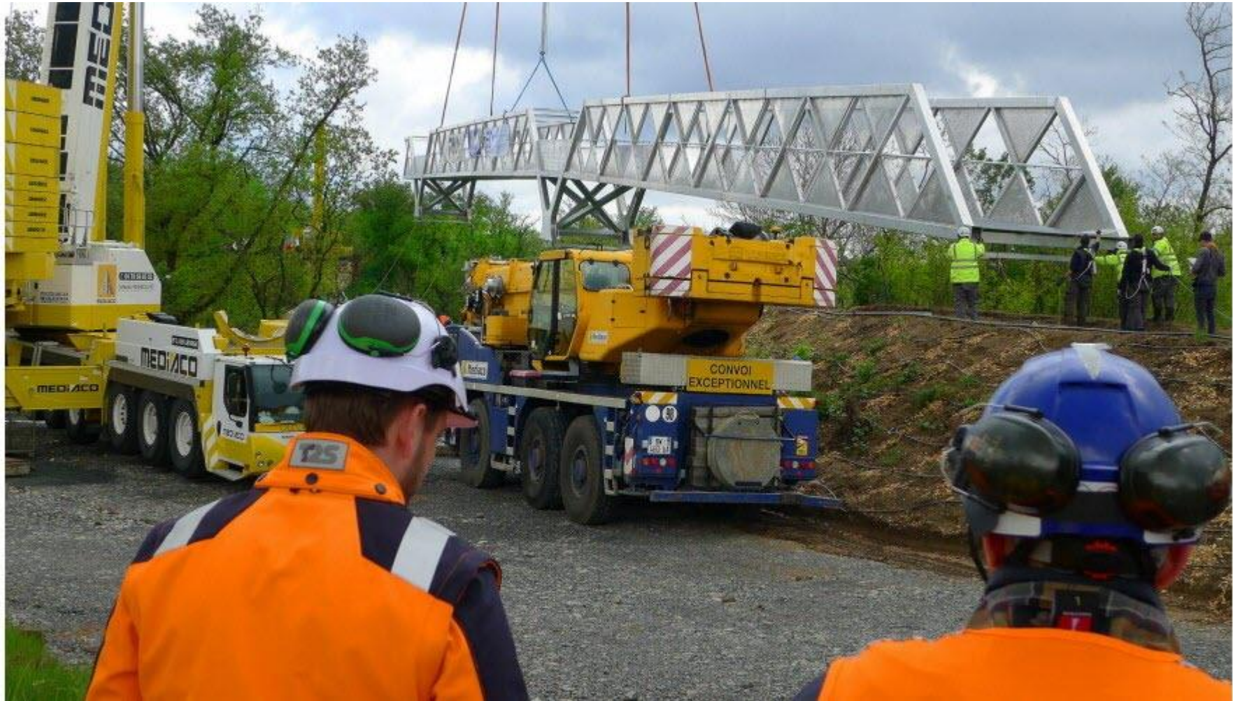
Le transport des tronçons de la passerelle jusqu'à Brindas a nécessité six convois exceptionnels de 30 mètres de longueur depuis la Vendée, lieu de sa conception par l'entreprise Atlantic Marine. Photo Thierry Huot
