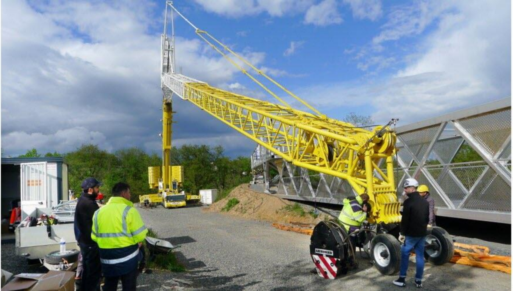
Après démontage, huit semi-remorques seront nécessaires pour évacuer la grue de 450 tonnes à un mètre. (Photo Thierry Huot)
